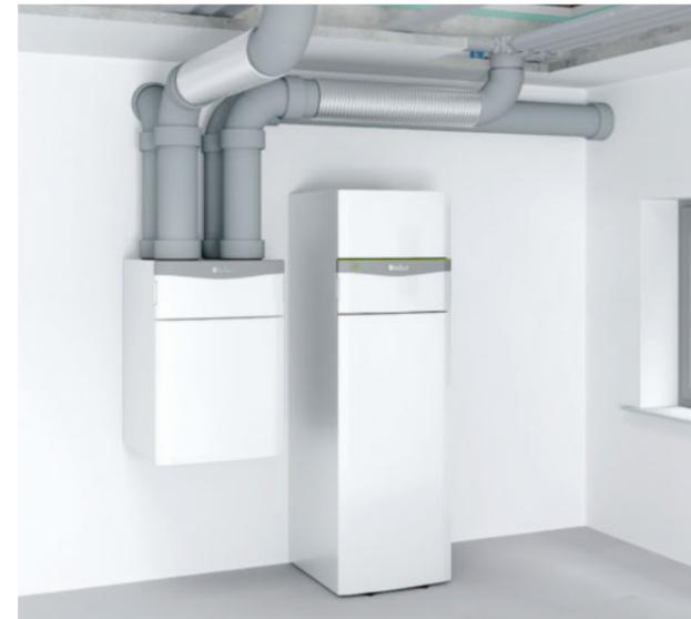
Zentrale Lüftung recoVAIR mit flexiblem Luftkanalsystem
